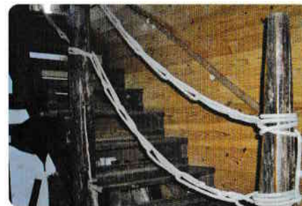
建設当時の階段
