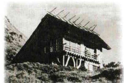
建設当時のあせび小屋
